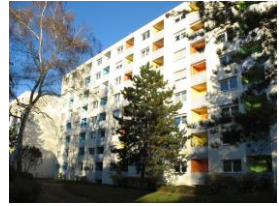
Instandsetzung Balkone / Laubengänge
